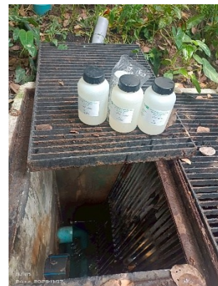
บ่อตรวจคุณภาพน้ำ พร้อมตะแกรงดักขยะ
